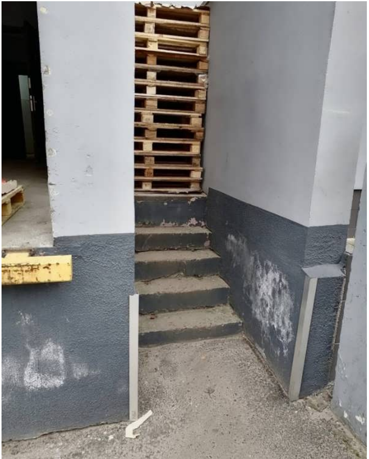
Проход на погрузо-разгрузочную рампу заставлен поддонами
