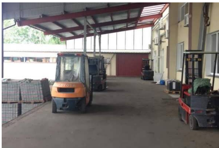
Отсутствуют колесоотбойные предохранительные устройства, препятствующие съезду и опрокидыванию безрельсового напольного транспорта
