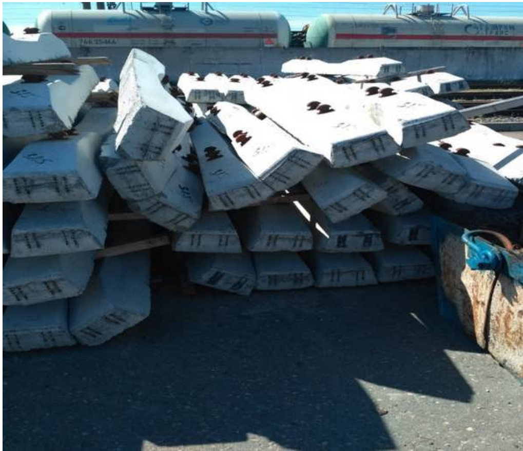
Не обеспечена безопасность складирования грузов
